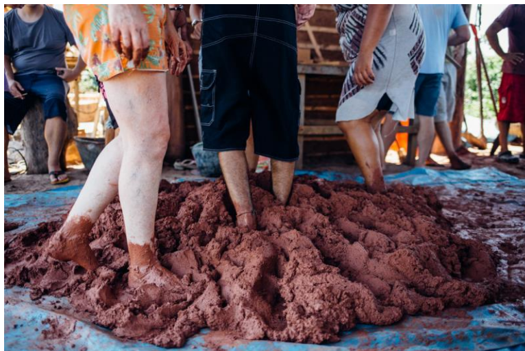
Figura 17: Preparo da massa de Terra. Fonte: Arquivo pessoal
