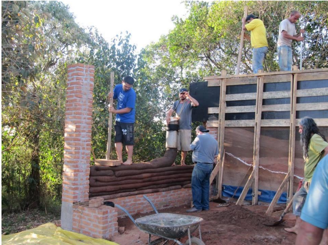
Figura 11: Fazendo paredes de Superadobe. Fonte: Michel Habbib, www.espacomaita.com.br
