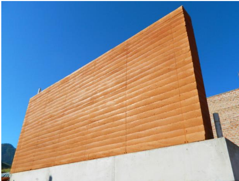
Figura 15: Parede de Taipa de Pilão. Fonte: http://sustentarqui.com.br/
