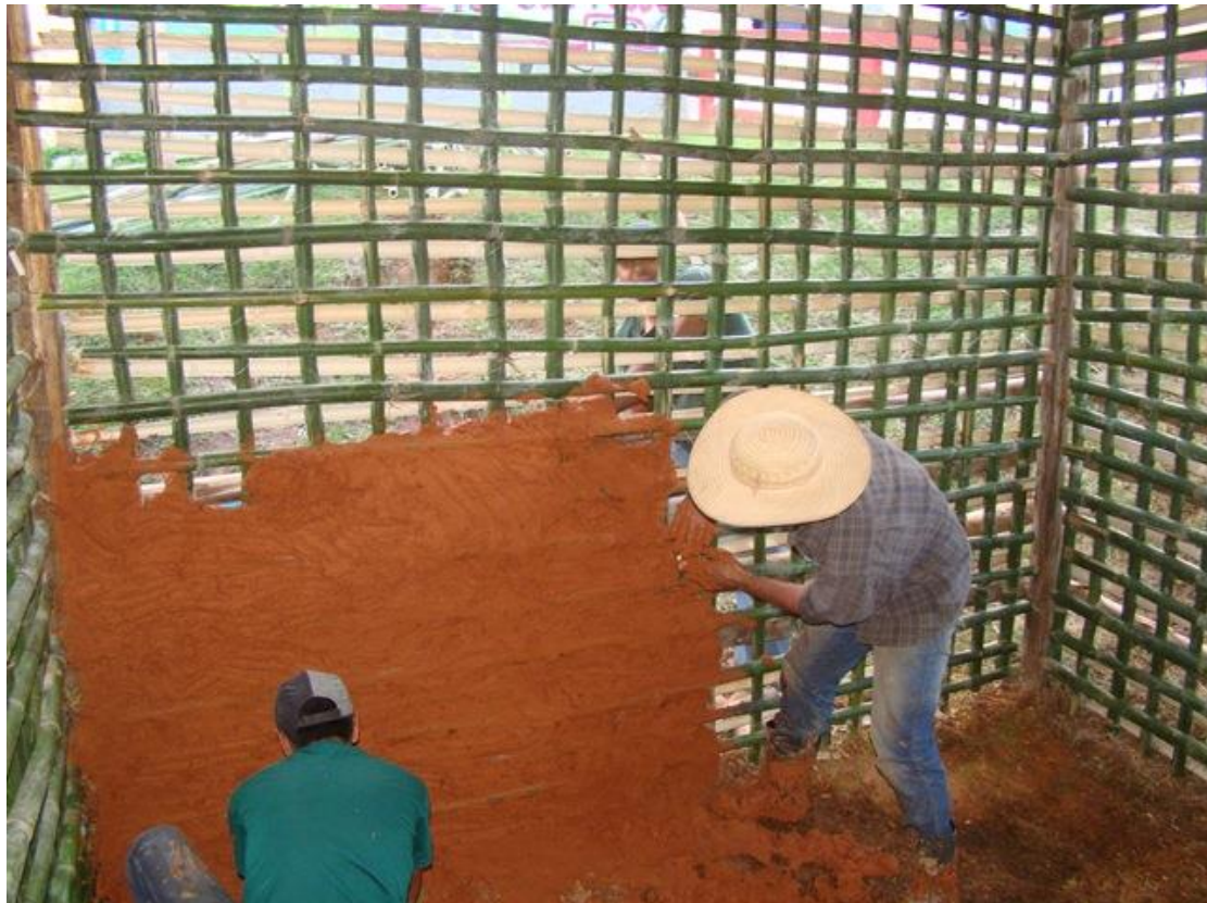
Figura 25: Preenchimento de parede de Taipa de Mão. Fonte: http://www.paraibuna.sp.gov.br/noticia.php?id=807
