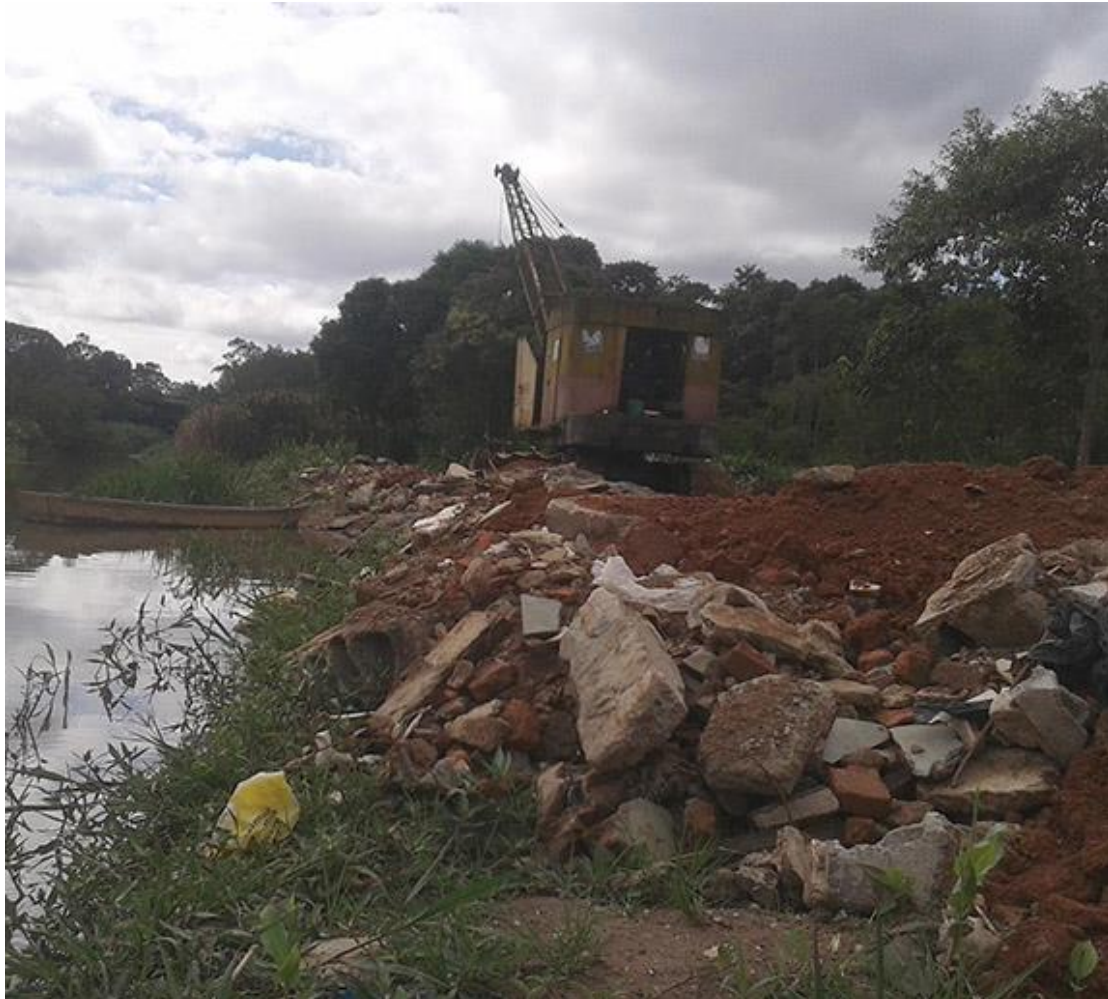
Figura 4: Descarte irregular de resíduos da construção civil. Fonte: http://www.folharibeiraopires.com.br/portal/exibeMateria.php?materia=21707
