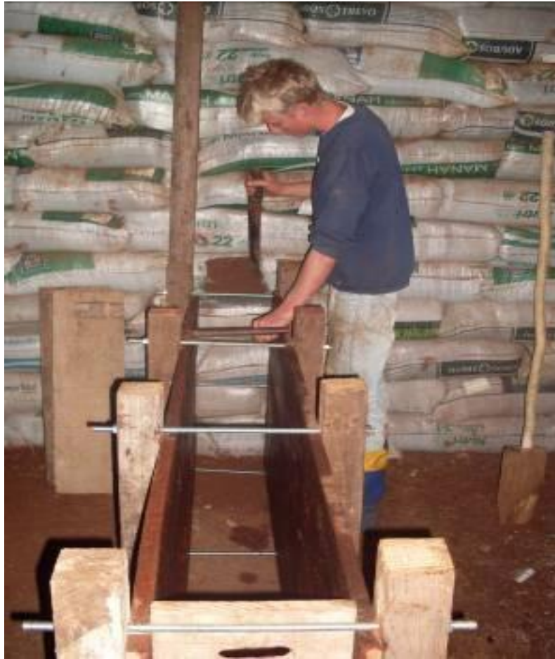
Figura 14: Forma da Taipa de Pilão. Fonte: http://www.ecoeficientes.com.br/taipa-de-pilao/
