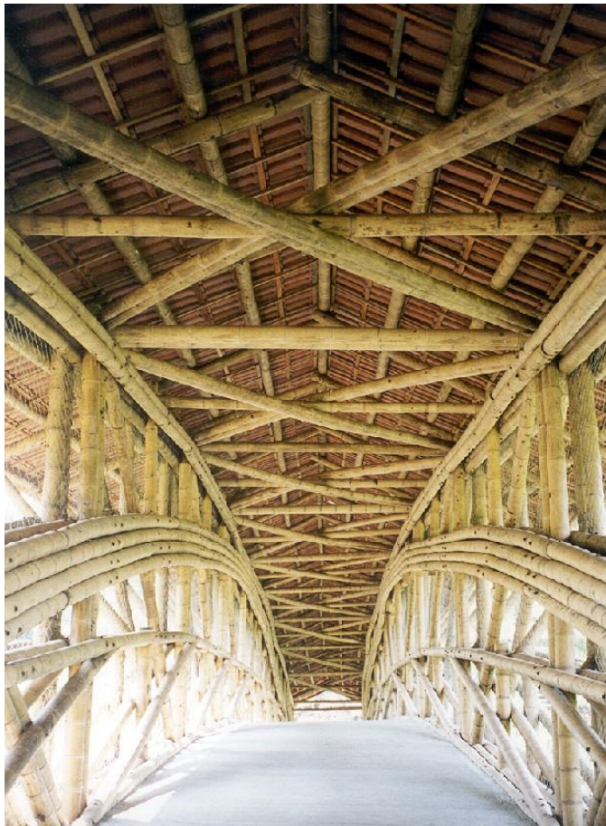
Figura 35: Ponte feita com bambu. Fonte: Foto cedida por Jorg Stamm
