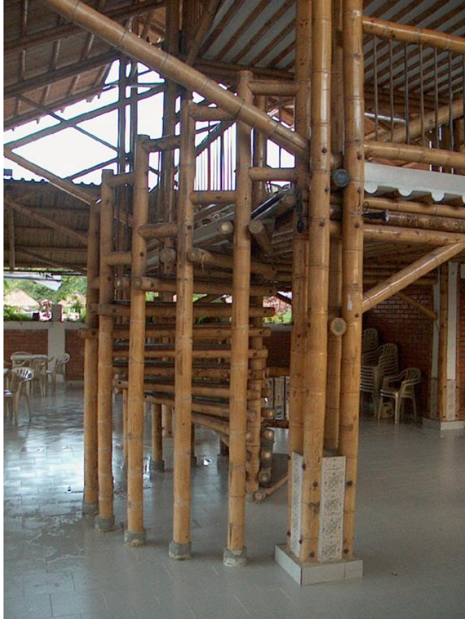
Figura 34: Casa com estrutura em bambu. Fonte: Foto cedida por Jorg Stamm
