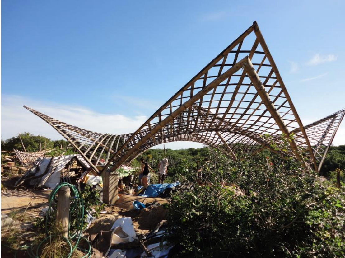
Figura 32: Paraboloide hiperbólico na sede do Tibá-Mar em Arraial do Cabo. Fonte: www.tibarose.com
