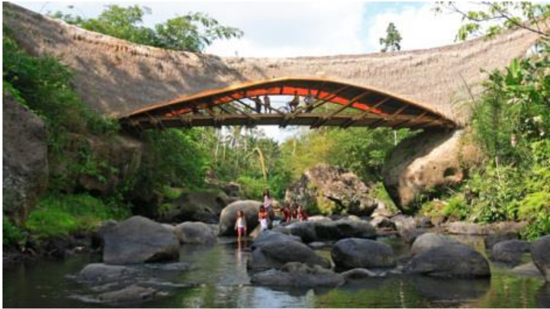
Figura 36: Ponte de bambu em Bali. Fonte: Foto cedida por Jorg Stamm
