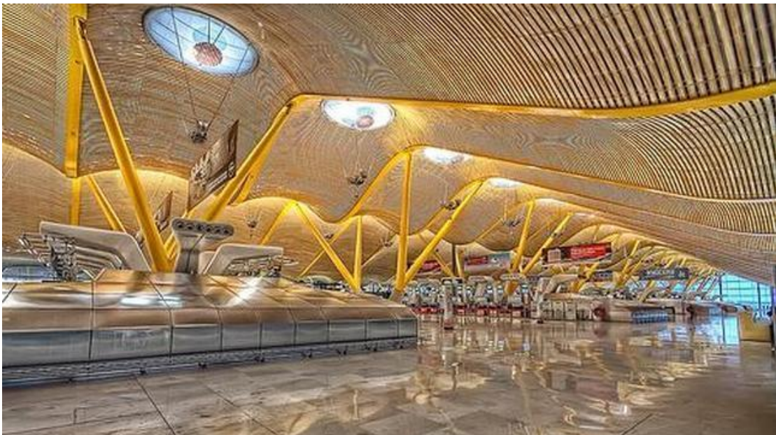
Figura 33: Aeroporto Barajas em Madrid. Telhado feito com laminados de bambu. Fonte: http://www.abc.es/20111212/cultura-arte/abci-national-geographic-barajas-201112121358.html
