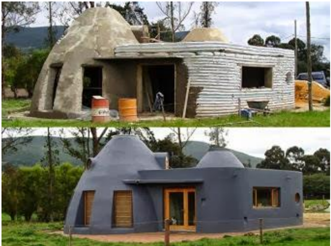
Figura 12: Casa feita em Superadobe. Fonte: Google imagens
