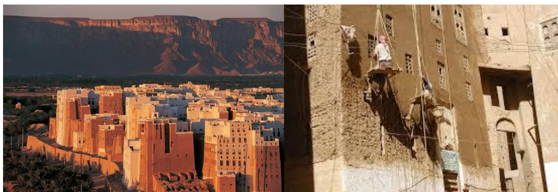
Figuras 6 e 7: Cidade de Shibam no Iêmen, edifícios construídos com blocos de lama seca (adobe).
