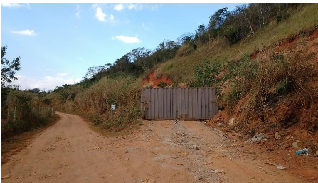
Figura 20: Portão de entrada do aterro controlado. Fonte: acervo próprio (10/10/2016)
