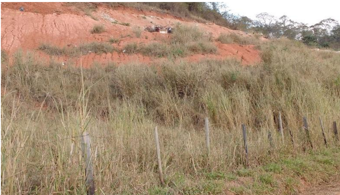
Figura 19: Cerca do aterro controlado. Fonte: acervo próprio (10/10/2016)
