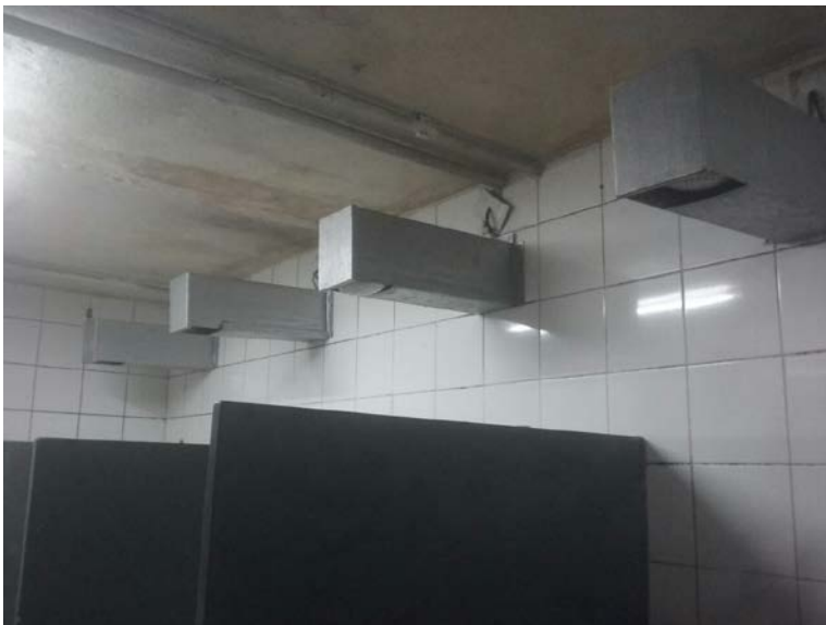
Figura 4 - Chuveiros do Albergue (Protegidos por uma estrutura de metal que visa evitar seu furto). Fonte: Própria (2017)
