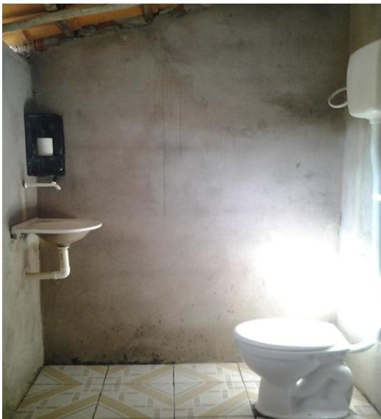
Figura 1 - Infraestrutura com encanamento intradomiciliar, composta por vaso sanitário, descarga, lavatório e chuveiro.
