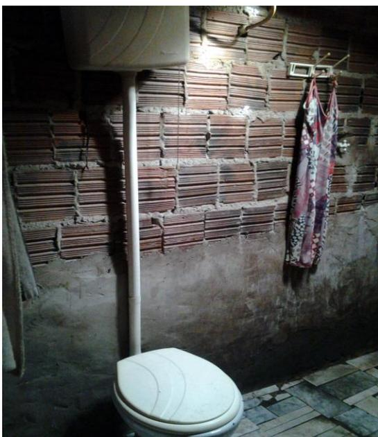
Figura 3 - Infraestrutura com encanamento intradomiciliar, composta por vaso sanitário. Apesar da presença de descarga a estrutura não funciona.
