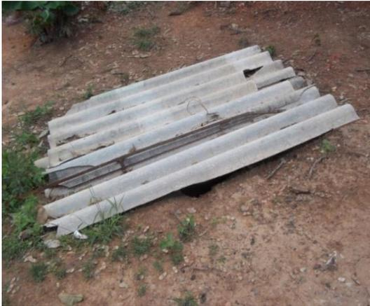
FIGURA 12 - Fossa negra tampada com um pedaço de telha de amianto.
