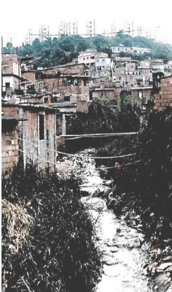
Figura 13: Vila Califórnia antes da canalização
