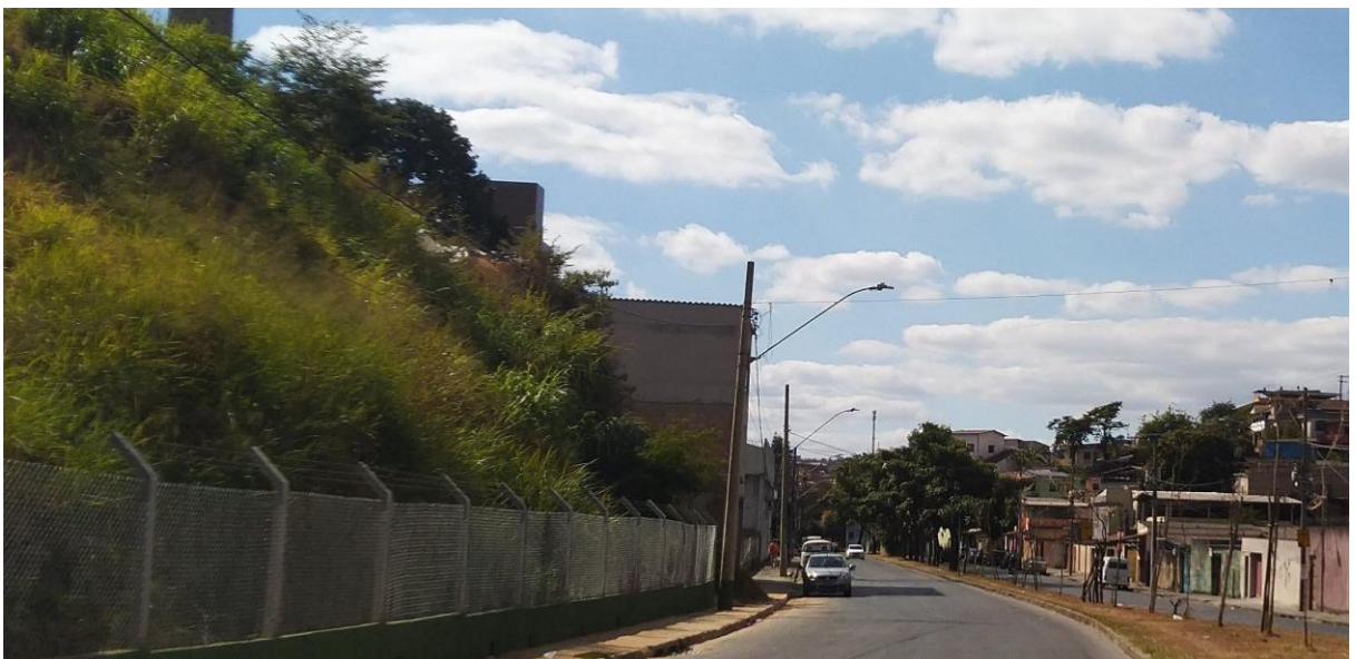
Figura 12: Avenida Avaí no Bairro Dom Bosco após as obras de canalização no trecho
