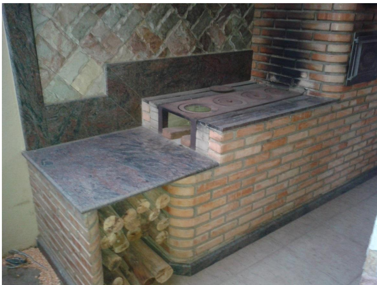
Figura 25. Fogão a lenha tradicional caipira (tipo poial) feito com tijolos refratários e argamassa.
