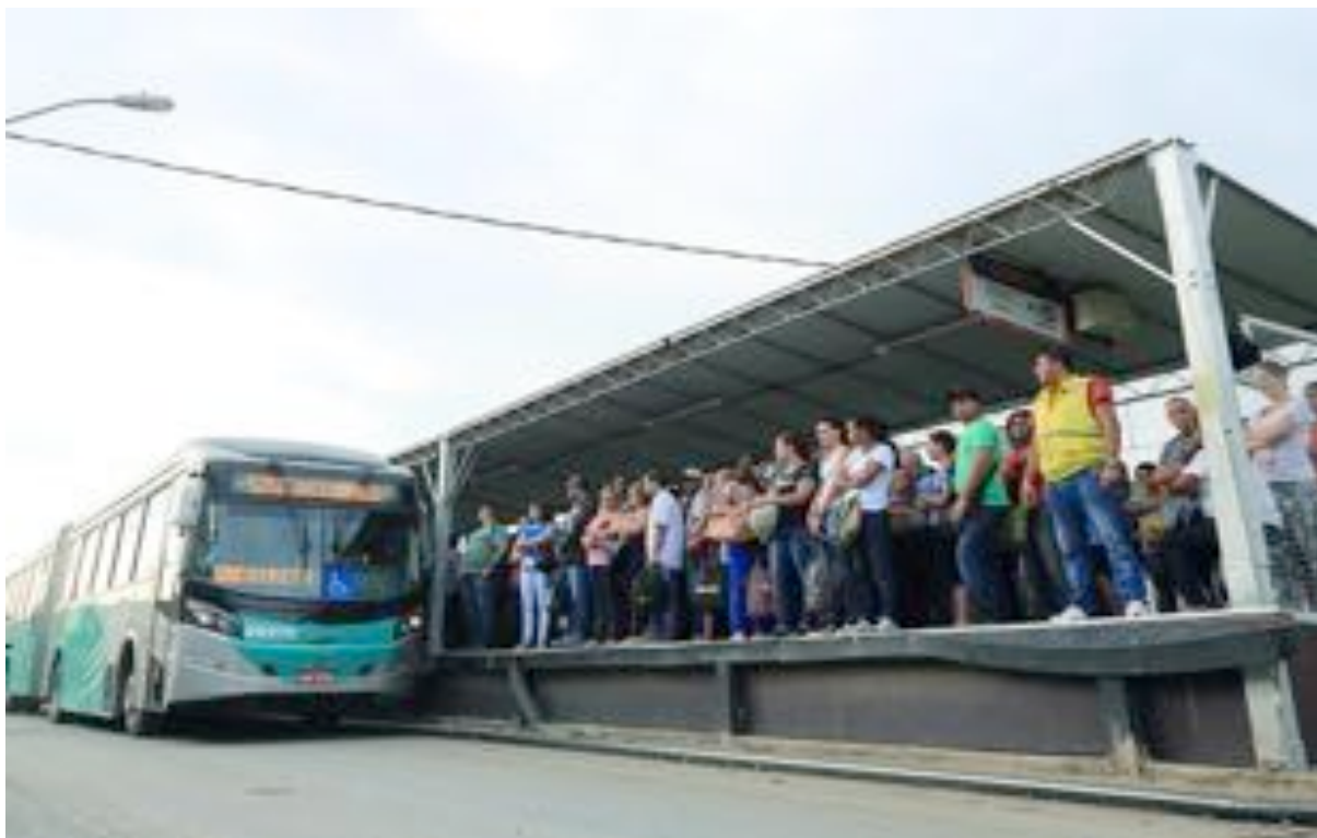
IMAGEM 2: Imagem da Estação (provisória) do Move de Justinópolis. A Estação Justinópolis (definitiva) deveria ser entregue no ano de 2014. A estação provisória é insegura e se encontra sobre um córrego como vemos na imagem 3. Disponível em: < http://migre.me/tQoit >. Acessado em: 13 de maio de 2016.
