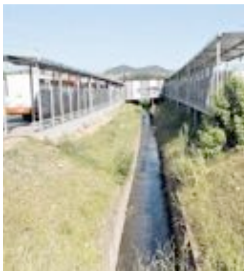
IMAGEM 3: Imagem do córrego onde se encontra a Estação (provisória) do Move de Justinópolis. Os usuários têm que esperar seus ônibus aguentando o mau cheiro do córrego. Disponível em: < http://migre.me/tQoEX >. Acessado em: 13 de maio de 2016.
